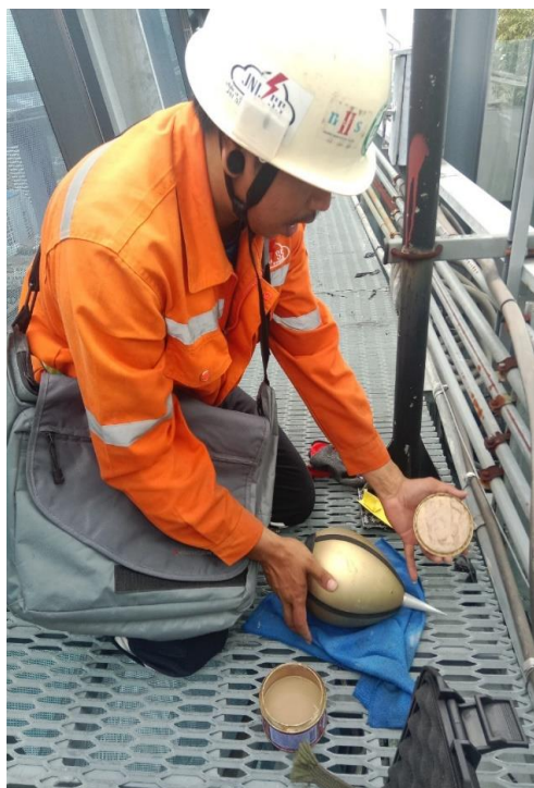
ภาพที่ 5-6 : ภาพแสดงการตรวจสอบและทำความสะอาดหัวล่อฟ้า (ต่อ)
