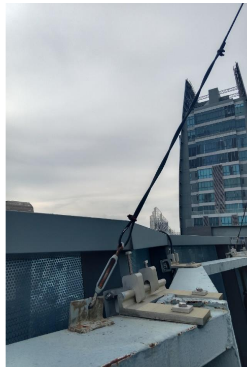
ภาพที่ 13-14-15-16 : ภาพแสดงการตรวจสอบอุปกรณ์ยึดโยงเสาหล่อฟ้า
