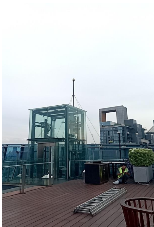
ภาพที่ 1-2 : ภาพแสดงการถอดหัวล่อฟ้าลงมาจากเสาเพื่อทำความสะอาดและทดสอบ
