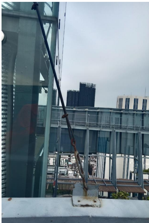
ภาพที่ 13-14-15-16 : ภาพแสดงการตรวจสอบอุปกรณ์ยึดโยงเสาหล่อฟ้า
